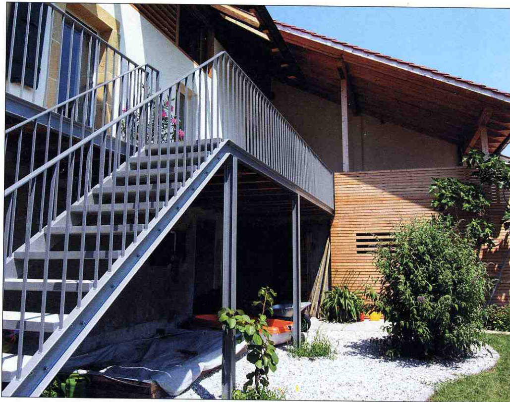
Accès à l'étage: l'ancienne terrasse du premier niveau, auparavant soutenue par trois piliers en béton, a été remplacée par une structure légère contemporaine en bois et métal qui met en valeur le caractère de la construction.
