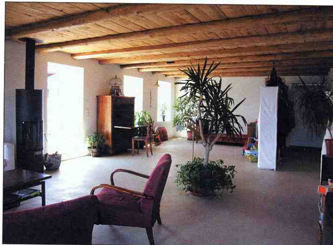
A l'étage supérieur, l'enlèvement d'un corridor traversant permet de mettre en valeur les solives d'origine courant d'une façade à l'autre du bâtiment.
