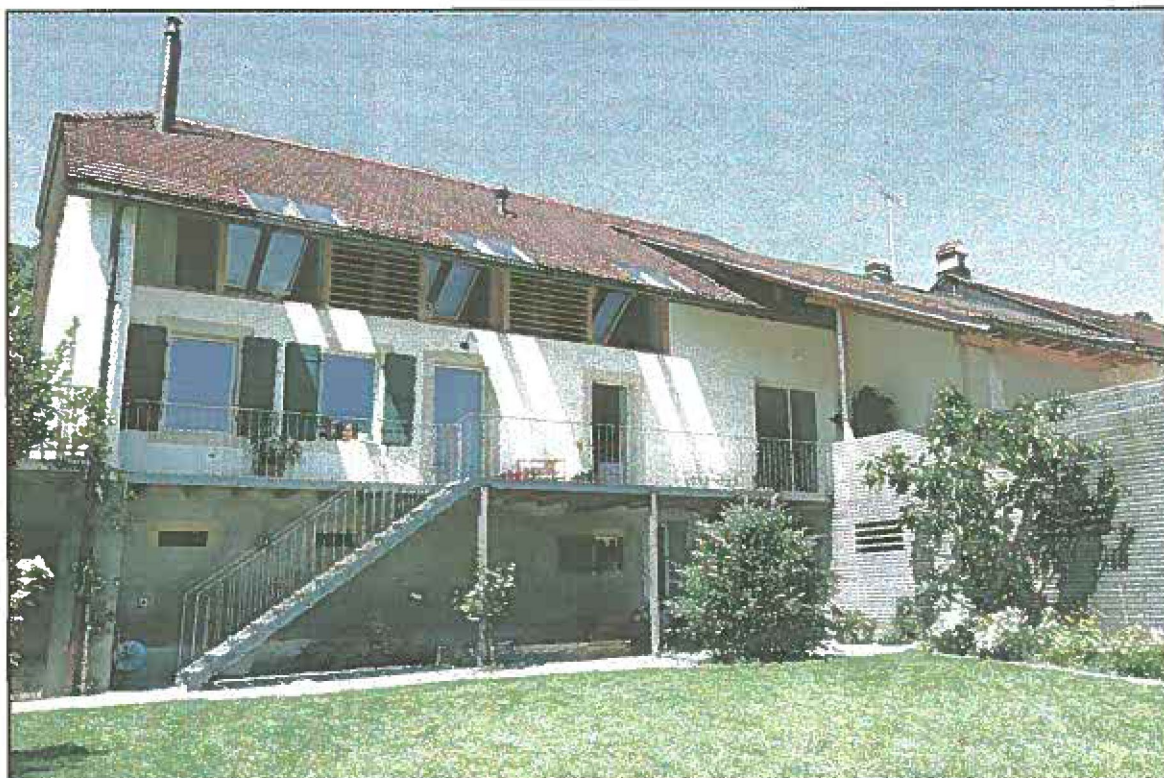
L'architecte Christophe Pulver a transformé à Praz une maison habitée en 1890 par un vigneron. DR
