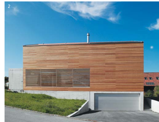
Grande image Le faite s'adapte au voisinage et s'oriente de la même façon. 1 Les lamelles de bois protègent la cage d'escalier d'une trop forte lumière et des regards indiscrets. 2 Le garage double est installé au sous-sol.
